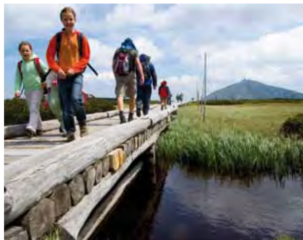
Przez poddane rewitalizacji Torfowisko Úpské zamiast wapiennego nasypu prowadzi wyniesiony nad powierzchnię dębowy chodnik na podporach. (zdjęcie z 2009 r., 13 lat po wybudowaniu, fot. Kamila Antošová)
