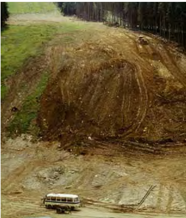
Niedostatecznie ustabilizowany stok Velkiego Bubna czarnej trasy zjazdowej na górze Svatý Petr w trakcie prac w latach 70. XX w. (fot. Jan Štursa)
