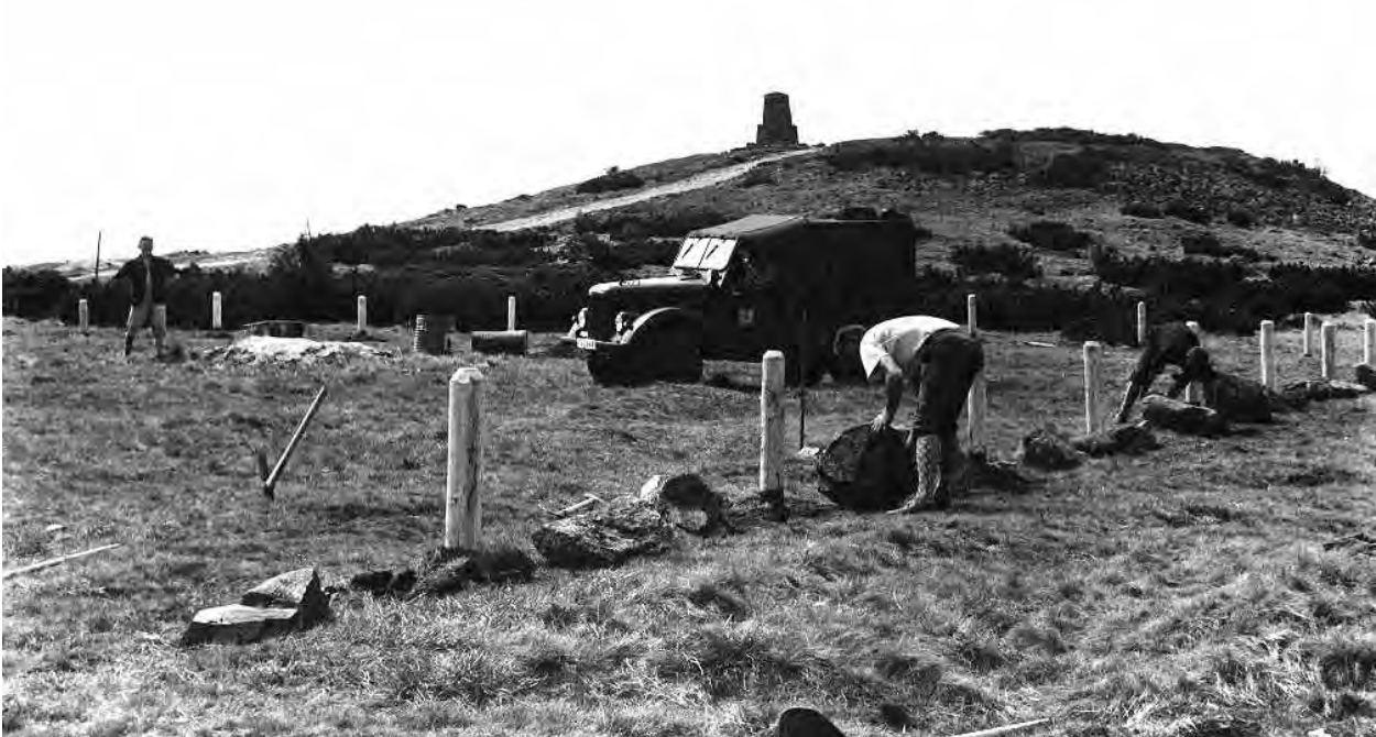
Budowa parkingu przy schronisku Vrbatova bouda. (fot. Miroslav Hladík)
