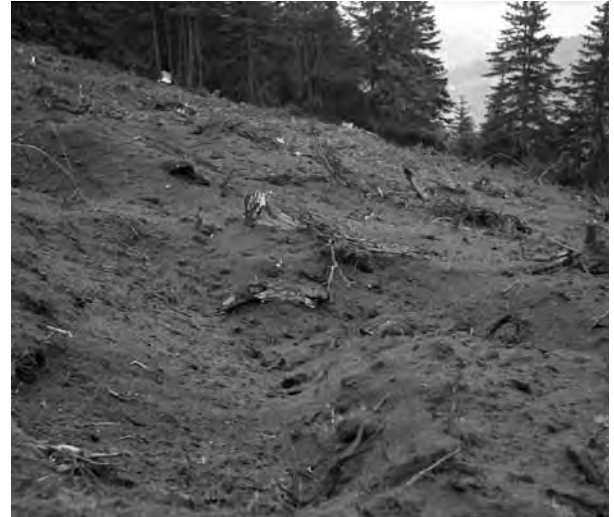
Żadne spychacze i przerzucanie ziemi oraz kamieni z jednego końca trasy zjazdowej na drugi. Po usunięciu pni członkowie i sympatycy Klubu Narciarskiego Spartak Rokytnice grabiami i taczkami precyzyjnie wyrównywali powierzchnię nowej trasy zjazdowej przed siewem. (fot. Jan Štursa)
