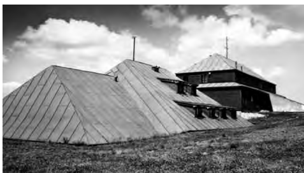
Dokończenie budowy schroniska Rýchorská bouda na potrzeby Ośrodka Edukacji Ekologicznej; wówczas noszącego jeszcze nazwę Ośrodka Wychowawczo-Kształcącego Państwowej Ochrony Przyrody, który otwarto w 1986 r. (fot. Jiří Bruník)
