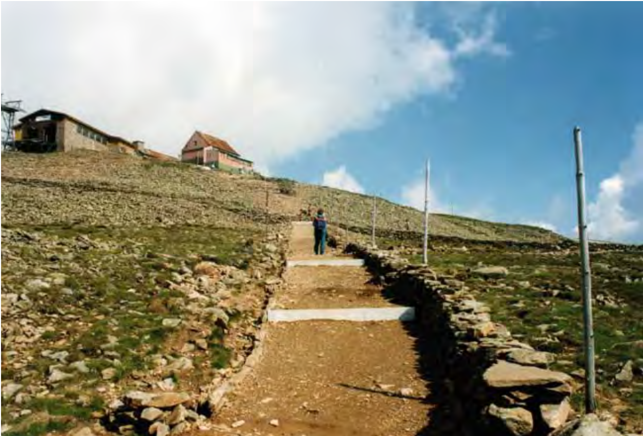
Na ogólny wygląd naprawionej drogi miały pozytywny wpływ również boczne murki z kamieni, które są ponadto skuteczną ochroną przeciwko niepożądanemu wychodzeniu turystów poza wyznaczoną drogę (chodzi o tzw. strefę ścisłej ochrony parku narodowego). Schronisko Česká bouda jeszcze stoi... (fot. Jan Štursa)
