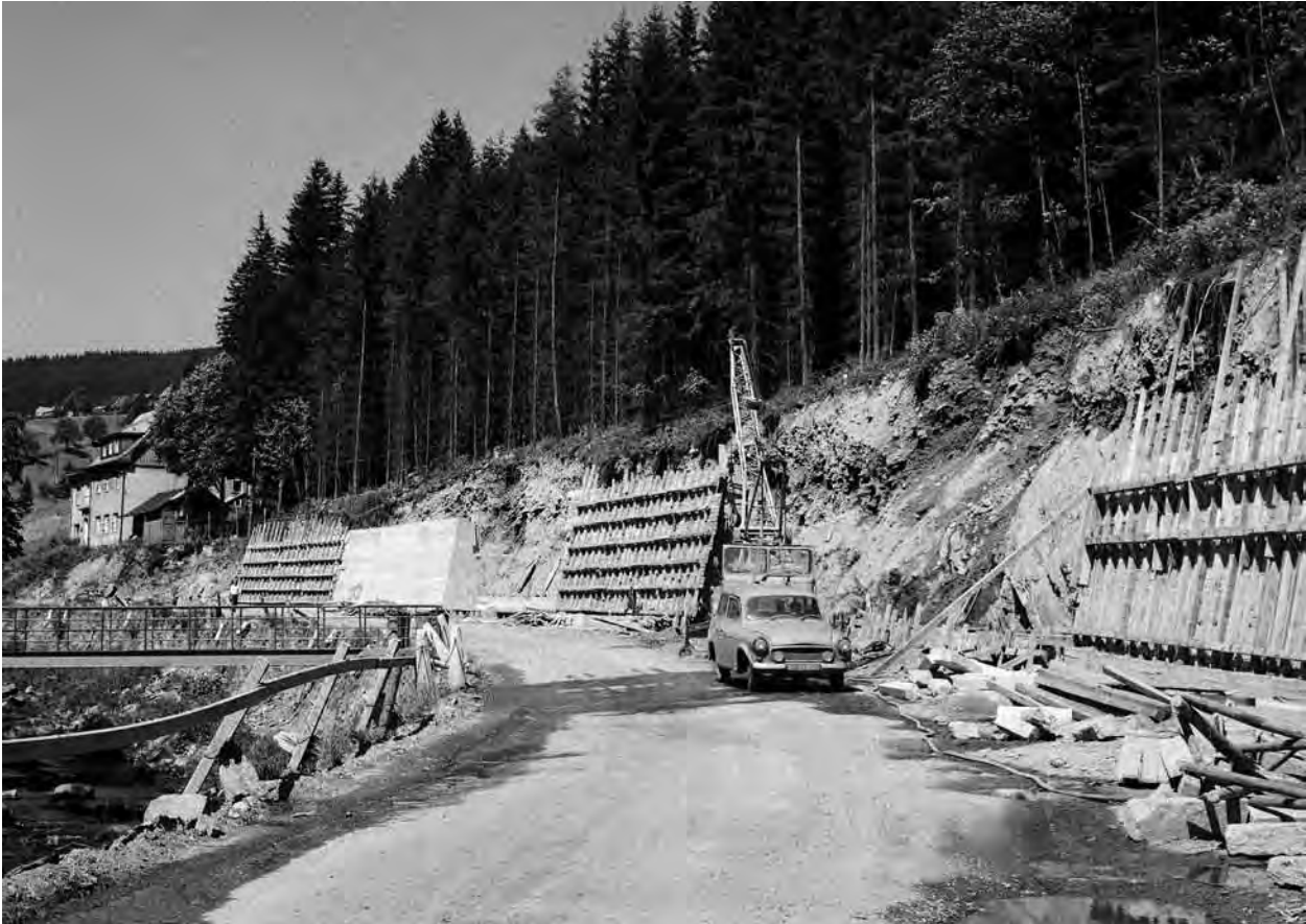
W 1969 r. przystąpiono do przebudowy wielu dróg prowadzących do ośrodków w Karkonoszach i do przejść granicznych. Polskie firmy budowlane stopniowo do 1977 r. poszerzyły następujące drogi: Horní Maršov–Pec pod Sněžkou (na zdjęciu), Vrchlabí–Špindlerův Mlýn , Temný Důl–Pomezň Boudy , Kořenov–Harrachov . Później przybyła obwodnica Harrachova, nie dość, że była zbędna, to jeszcze niepotrzebnie szeroka. (fot. Miroslav Hladík)
