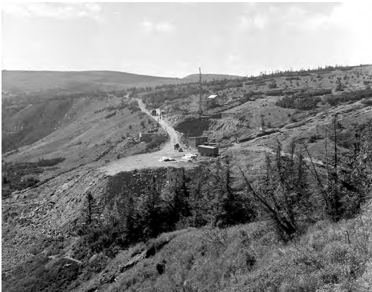
Budowę nowego budynku schroniska Labská bouda poprzedziły przeprowadzane na dużą skalę prace ziemne, co nieodwracalnie naruszyło przyrodę w okolicy niszy niwalnej Labská jáma. (fot. Jan Štursa)
