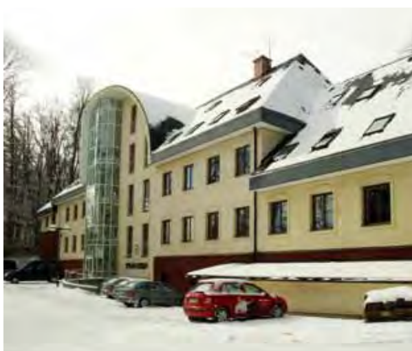
Oddział Dyrekcji Karkonoskiego Parku Narodowego we Vrchlabí długo mieścił się w pałacu, w budynku muzeum i w dwóch prowizorycznych drewnianych barakach. Po połączeniu z zakładami gospodarki leśnej wybudowano nową siedzibę. (ukończoną w 1996 r., fot. Kamila Antošová)
