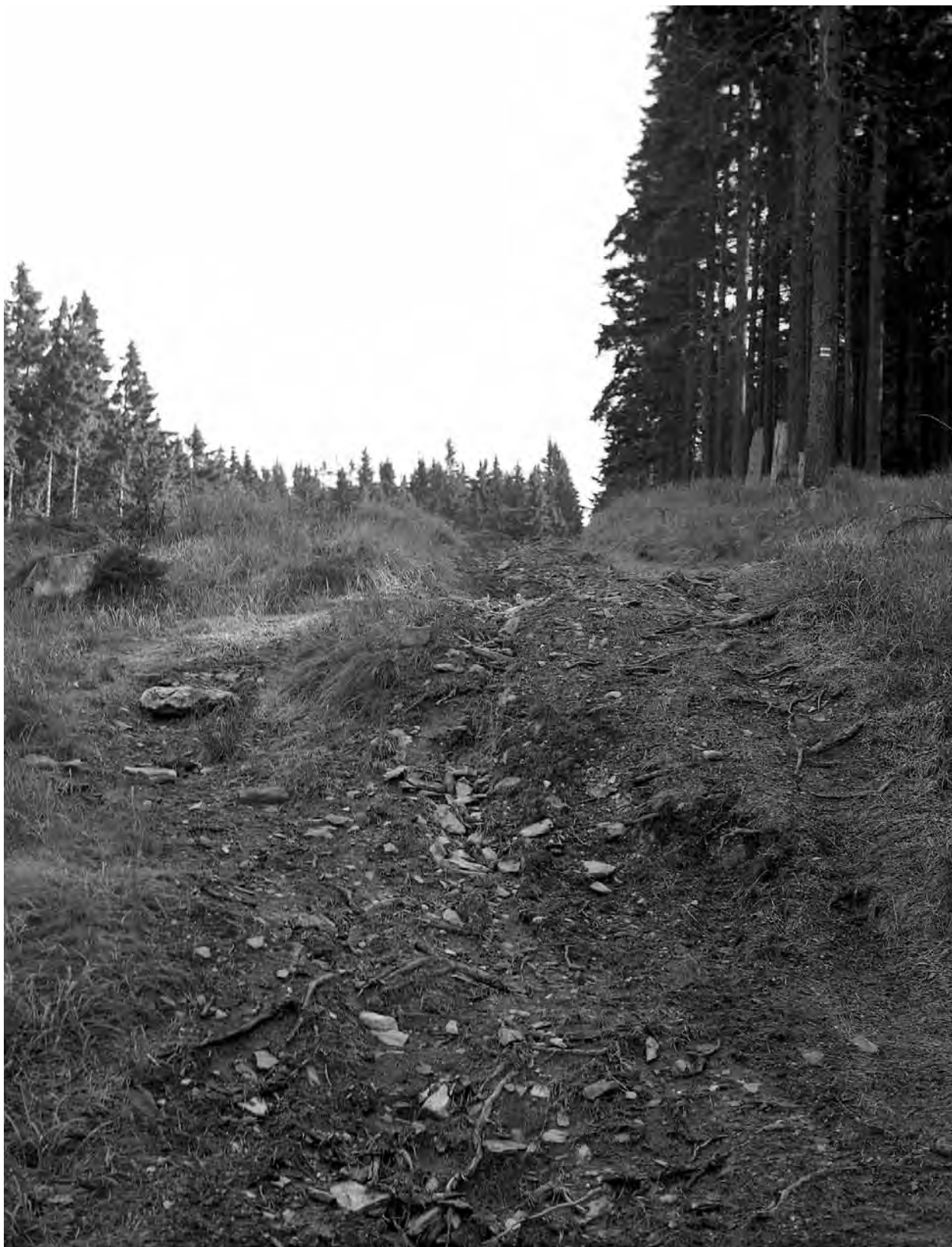
Koła motocykli uformowały w niektórych miejscach garb pomiędzy koleinami na drodze, gdzie indziej wytworzyły koryta, które stanowią bazę dla szybko postępującej erozji wodnej. (fot. Jan Štursa)
