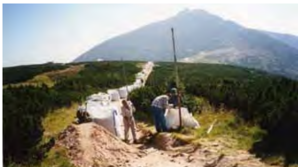
Setki ton wapienia pozostałe z drogi prowadzącej od torfowiska Úpské rašeliniště pod Śnieżkę zostały w workach odtransportowane helikopterem. Skomplikowaną rekonstrukcję drogi w 2001 r. finansowało czeskie Ministerstwo Środowiska w ramach Programu Ochrony Krajobrazu. (fot. Jan Štursa)
