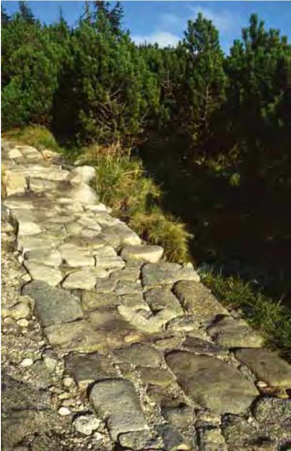
Droga ułożona z kamieni prowadząca od schroniska Labská bouda do krawędzi Śnieżnych Kotłów jest przykładem precyzyjnej pracy górskich drogomistrzów, którzy nawiązali do tradycyjnych metod swych poprzedników. (fot. Jan Štursa)
