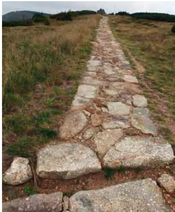
Droga do Kamieni Harracha jest stosunkowo wąska i wyłożona grafitowymi kamieniami. Zastąpiła szerszą żwirową drogę. (2011, fot. Kamila Antošová)
