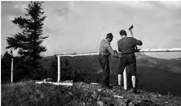
Die Rekonstruktion der Wanderwege – eine wirksame Maßnahme zur Regulierung der Touristenströme. Hier errichteten Mitarbeiter der KRNAP-Verwaltung die Šmíd-Aussicht am Osthang des Riesengebirgskammes. 60er Jahre (Foto Miroslav Hladík)
