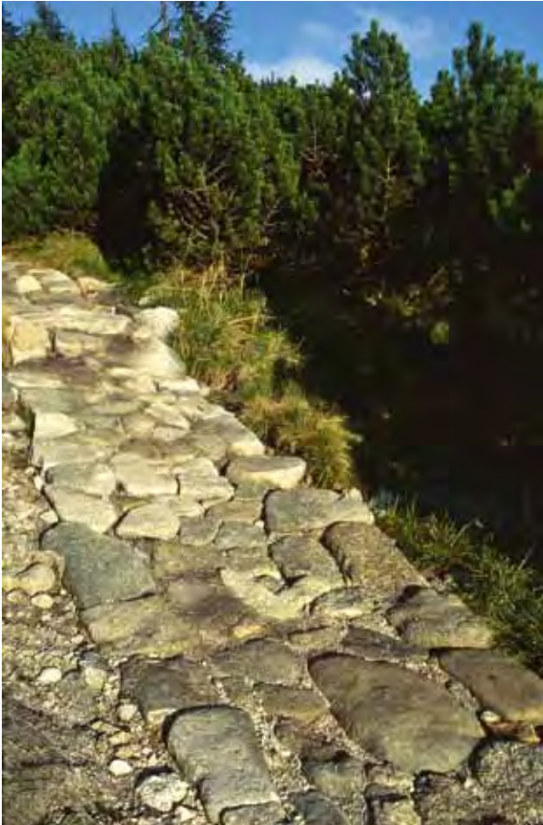
Der steingepflasterte Weg von der Labská bouda zur Kante der Schneegruben ist ein Aunschauungsbeispiel der sensiblen Arbeit der heutigen Wegebauer, die an die traditionellen Methoden ihrer Vorgänger aus alter Zeit anknüpfen (Foto Jan Štursa)
