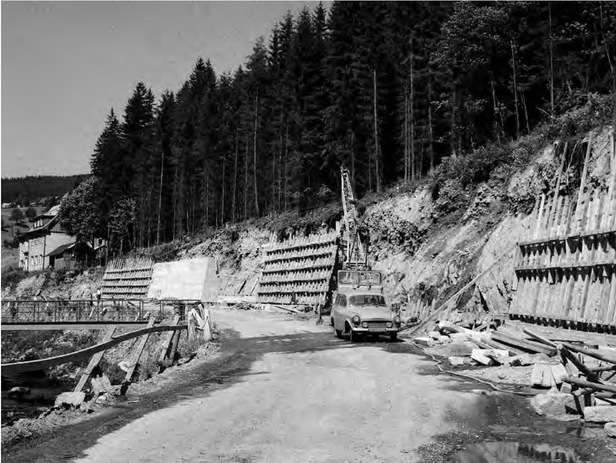
1969 nahm man eine ganze Serie von Umbauten der Verkehrswege zu den Riesengebirgszentren und Grenzübergängen in Angriff. Eine polnische Baufirma erweiterte bis 1977 schrittweise die Gebirgsstraßen Horní Maršov – Pec pod Sněžkou (siehe Foto), Vrchlabí – Špindlerův Mlýn, Temný Důl – Pomezní Boudy sowie Kořenov – Harrachov. Dann kam noch die Umgehungsstraße von Harrachov hinzu. Getreu dem Grundsatz: Je sinnloser, desto breiter (Foto Miroslav Hladík)
