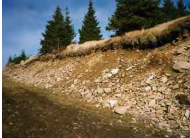
Detailaufnahme vom Medvědíň: Gut und schlechter stabilisierter Pistenrand. Rutschendes Gestein und das Abrutschen der Oberkante verlängern den Stabilisierungsprozess des Seitenhanges um viele Jahre. Darüber hinaus beeinträchtigt dies die Präparierung der Piste und deren Sicherheit im Vorfrühling (Foto Jan Štursa)
