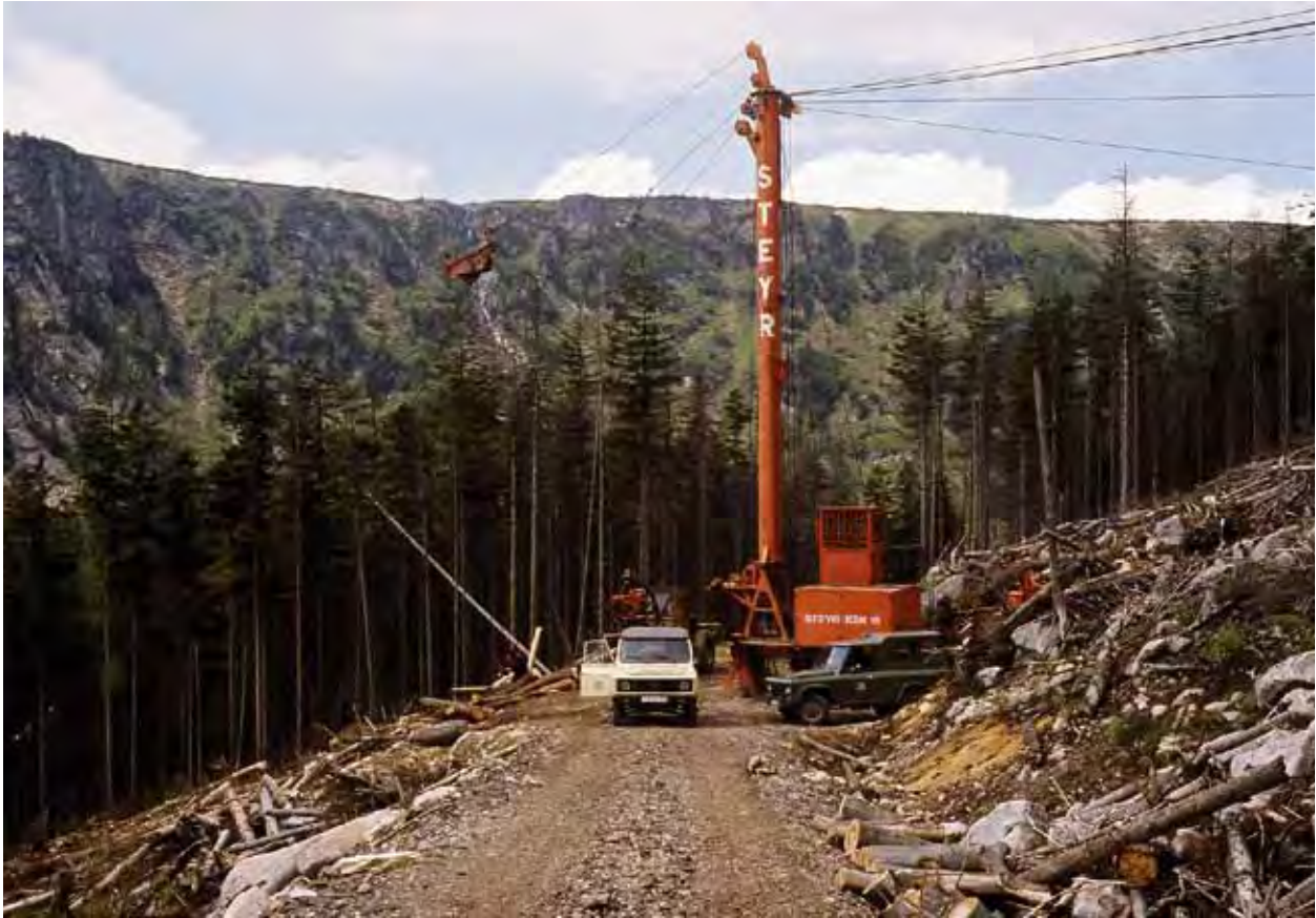
Die Seilbahn Steyr an der Rückegasse Lavina im Elbgrund (Labský důl) (hinter der Laufkatze ist der Pantschefall zu sehen). Der tägliche Umfang der transportierten Masse dieser leistungsfähigen österreichischen Maschine war gewaltig und so wandelte sich der Charakter der streng geschützten Riesengebirgslandschaft von Tag zu Tag (Foto Jan Štursa)
