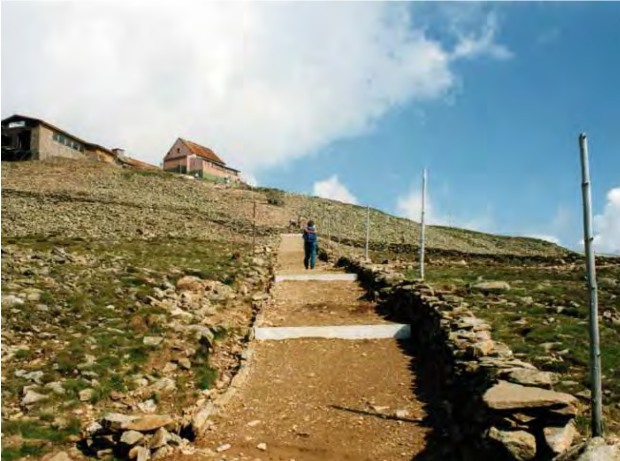
Den Gesamteindruck des reparierten Weges verbessern auch die niedrigen, steingemauerten Randwände – ein wirksamer Schutz vor dem ‚Ausschwärmen‘ der Wanderer in die Umgebung des Wanderweges (in der 1. Zone des NP mit strengstem Schutzregime). Hier steht die Böhmisches Baude noch... (Foto Jan Štursa)
