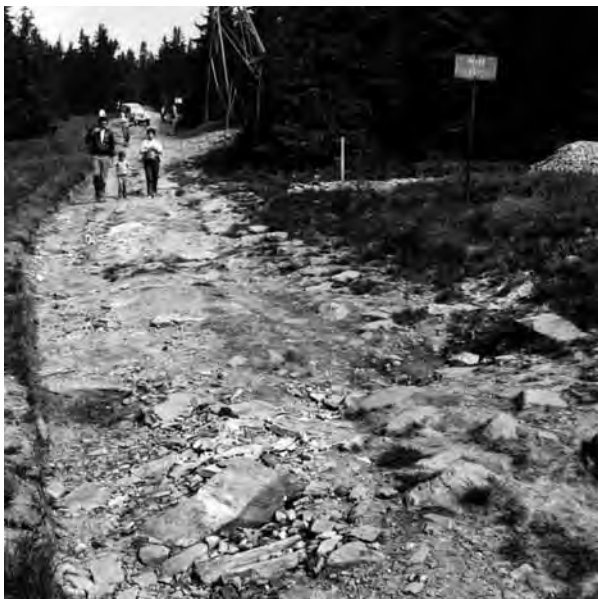
Der Weg zum Gipfel der Schneekoppe führt am Rosenberg (Růžova hora), unter der Seilbahn entlang. Der Steinsatz des Weges wurde durch Millionen Schritte zerstört, erst in den 90er Jahren wurde er dann rekonstruiert (Foto Fotoarchiv der KRNAP-Verwaltung)
