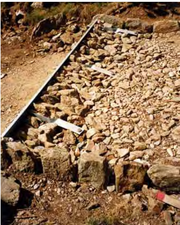
Das System der sturzgepflasterten Quer- und Seitengräben verhindert die unerwünschte Wegschwemmung des Wegbelages, da diese die erosive Kraft des Oberflächenwassers bei intensiveren Niederschlägen oder durch tauenden Schnee verringern. Langfristig ist der perfekte Zustand des reparierten Weges jedoch von der regelmäßigen Pflege der Wegebauer abhängig (Foto Jan Štursa)
