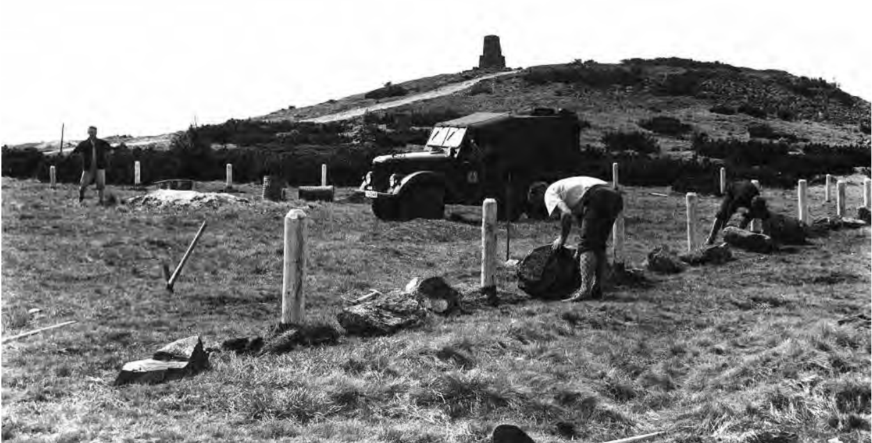
Errichtung des Parkplatzes bei der Vrbata-Baude (Foto Miroslav Hladík)
