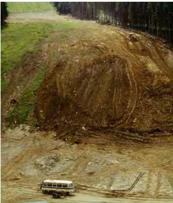
Der unzureichend stabilisierte Hang ‚Velký buben‘ der schwarzen Piste in Svatý Petr im Laufe der Terrainarbeiten in den 70er Jahren des 20. Jahrhunderts (Foto Jan Štursa)
