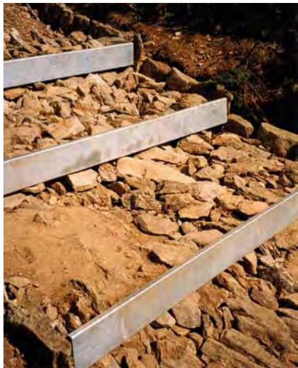
Das System der sturzgepflasterten Quer- und Seitengräben verhindert die unerwünschte Wegschwemmung des Wegbelages, da diese die erosive Kraft des Oberflächenwassers bei intensiveren Niederschlägen oder durch tauenden Schnee verringern. Langfristig ist der perfekte Zustand des reparierten Weges jedoch von der regelmäßigen Pflege der Wegebauer abhängig (Foto Jan Štursa)
