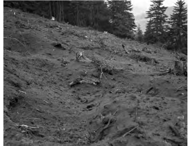
Keine Bulldozer und kein Hin- und Herschieben von Erd- und Gesteinsmassen von einem zum anderen Ende der Piste. Nach dem Heraussprengen der Baumstümpfe wurde das Terrain der neuen Piste von Mitgliedern und Anhängern des Spartak Rokytnice vor der Aussaat behutsam mit Harken und Schubkarren geebnet (Foto Jan Štursa)
