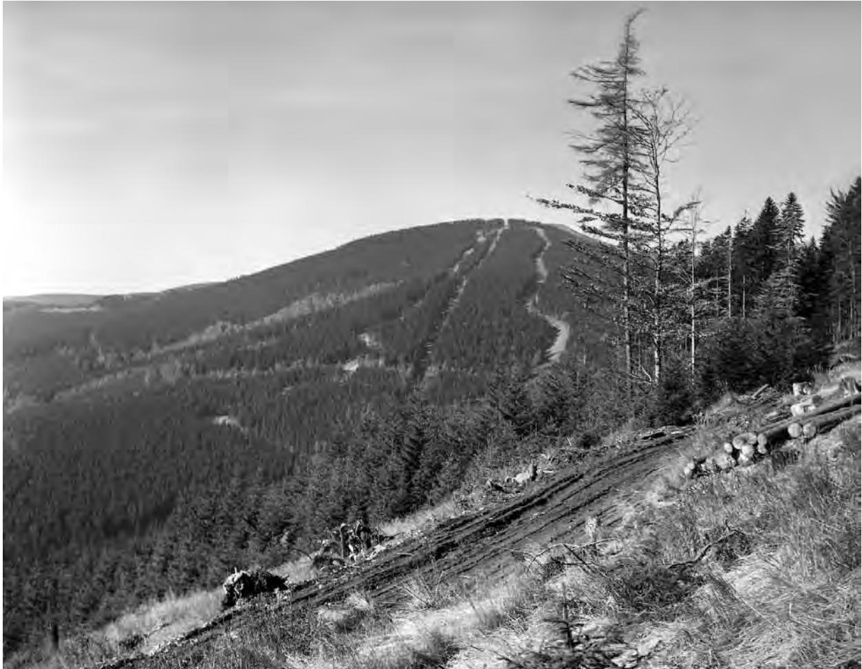
Das Skigebiet am Schüsselberg (Medvědíň) lag inmitten tiefer Wälder – bevor der saure Regen sein verheerendes Werk begann. Der größte Teil des Hanges rund um die Skipisten wurde in den 80er Jahren abgeholzt. Auf dem Berggipfel kamen inzwischen Sendetürme hinzu (Foto Jan Štursa)
