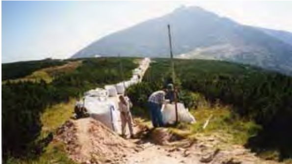
Hunderte Tonnen Kalkstein vom Weg durch das Aupa-Hochmoor (Úpské rašeliniště) unter der Schneekoppe wurden per Hubschrauber in Säcken abtransportiert. Die aufwendige Rekonstruktion des Weges im 2001 wurde vom Umweltministerium im Rahmen eines Landschaftspflegeprogramms finanziert (Foto Jan Štursa)
