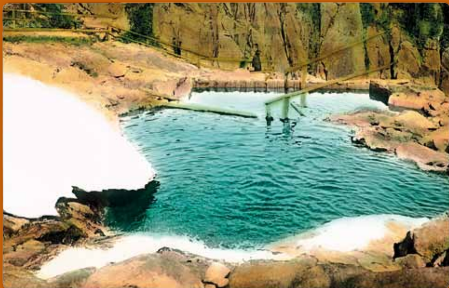
Na snímku Josefa Vejnar z roku 1904 je dvojice nádržek nad Labským vodopádem s dobře patrnými pákami výpustí a zábradlím chodníku pod vodopád
