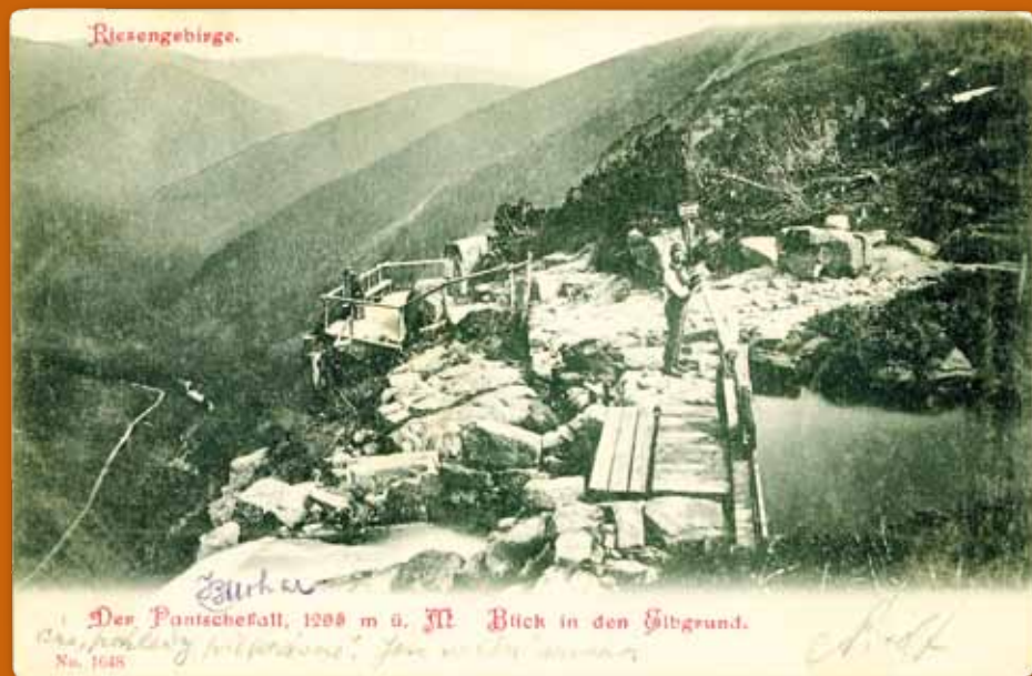
Zaniklá nádržka na navyšování průtoku nad Pančavským vodopádem
