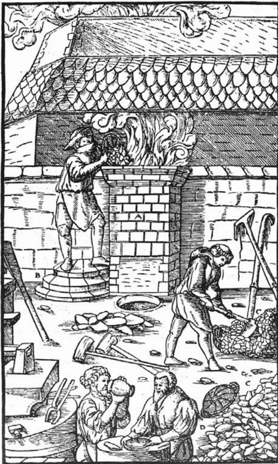
W czasach Gendorfa do wytopu rudy żelaza wykorzystywano podobne, stosunkowo małe piece. Na tych terenach wielkie piece rozpowszechniły się dopiero w późniejszym okresie. J. Agricola.
