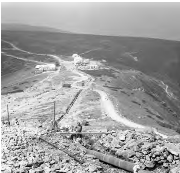
Výkop sdruženého vedení vody, elektřiny a telefonu, 1974. Přestože bylo mělce uložené vedení zaházeno kamením, je dnes znovu dobře patrné (foto Jan Štursa)
