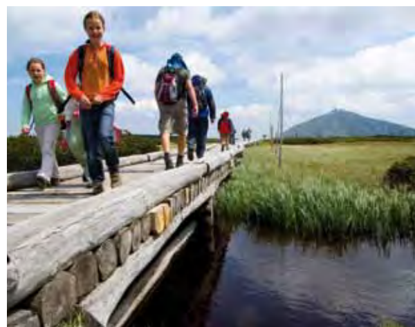
Přes revitalizované Úpské rašeliniště vede místo vápencového náspu povalový dubový chodník na pilotách (snímek z roku 2009, 13 let od výstavby, foto Kamila Antošová)
