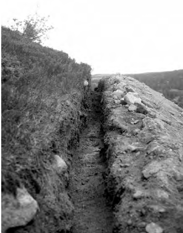
Nesprávná trasa výkopu odpadu z biologického septiku nové Labské boudy směřovala přímo do přísně chráněné Navorské jámy. Na omyl se naštěstí přišlo včas a terén se podařilo asanovat (foto Jan Štursa)
