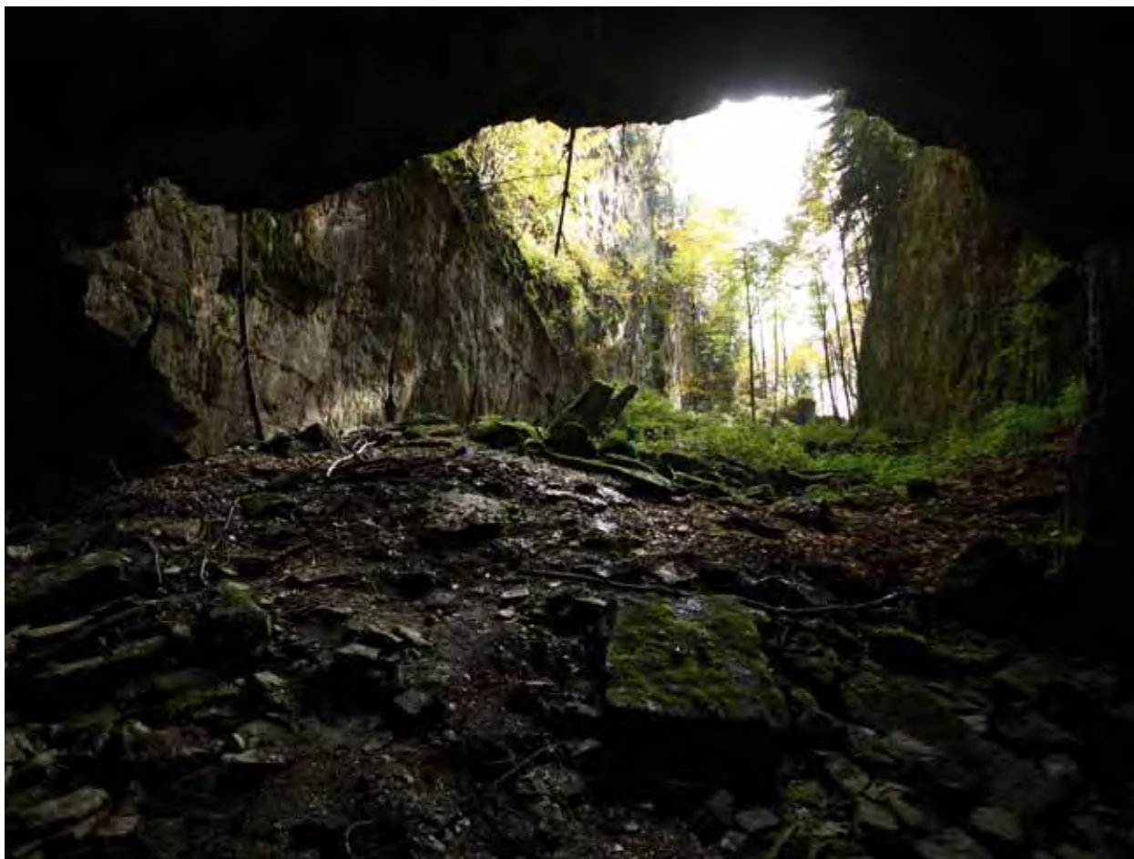
Vylámaná tunelovitá komora v nejnižší části Albeřického lomu bývá sezonně do výše 1 až 2 metrů zaplavena vodou (foto Radek Drahňý)
