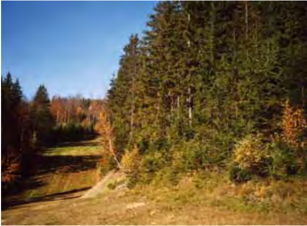
Detaily z Medvědína: dobře a špatně stabilizovaný okraj sjezdovky. Klouzající kameny a sesouvání horní hrany prodlužují stabilizaci bočního svahu na mnoho let. Zhoršuje to i úpravu povrchu sjezdovky a její bezpečnost v předjarním období (foto Jan Štursa)
