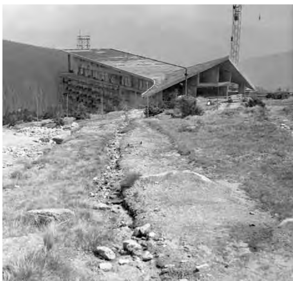
Poškození terénu v trase vodovodu pro novou Labskou boudu (foto Jan Štursa)
