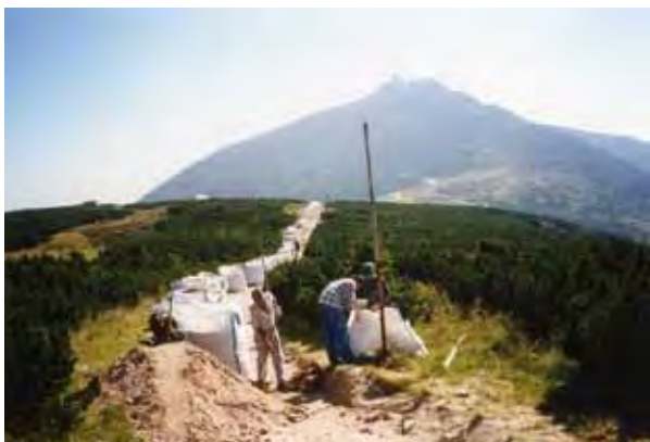
Zbývající stovky tun vápence z cesty od Úpského rašeliniště pod Sněžku byly v žocích odneseny vrtulníkem. Náročnou rekonstrukcí cesty v r. 2001 financovalo MŽP v rámci Programu péče o krajinu (foto Jan Štursa)
