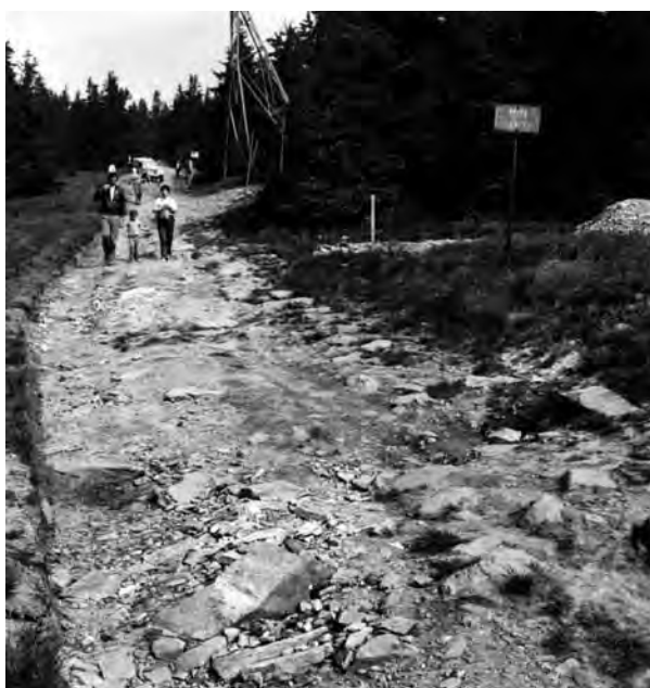
Cesta na Sněžku podchází na Růžové hoře lanovku. Štět byl zničen miliony kroků, cesta se dočkala rekonstrukce až v 90. letech (foto archiv Správy KRNP)
