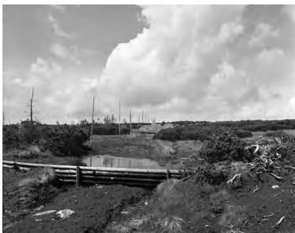
Přehrážky na bývalé cestě od Labské na Voseckou boudu zabraňují erozi způsobenou sešlapem podmáčeného terénu a přispívají ke stabilitě vodního režimu Pančavského rašeliniště (snímek z roku 1995, foto Karel Hník)
