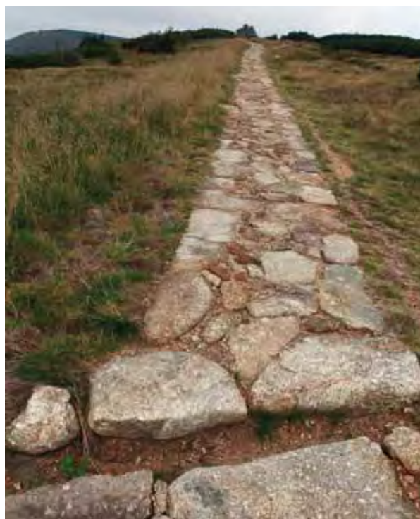
Cesta k Harrachovým kamenům je poměrně úzká a dlážděná žulovými kameny. Nahradila širší šterkovou cestu (2011, foto Kamila Antošová)
