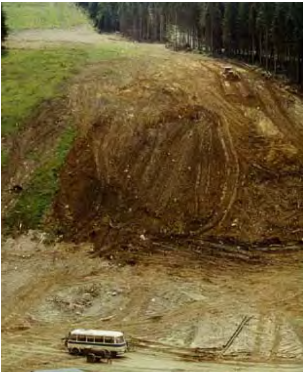
Nedostatečně stabilizovaný svah Velkého bubnu černé sjezdovky ve Svatém Petru během úprav v 70. letech 20. století (foto Jan Štursa)
