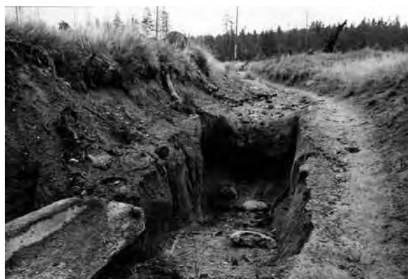
I takto vypadaly cesty postižené erozí (foto archiv Správy KRNP)
