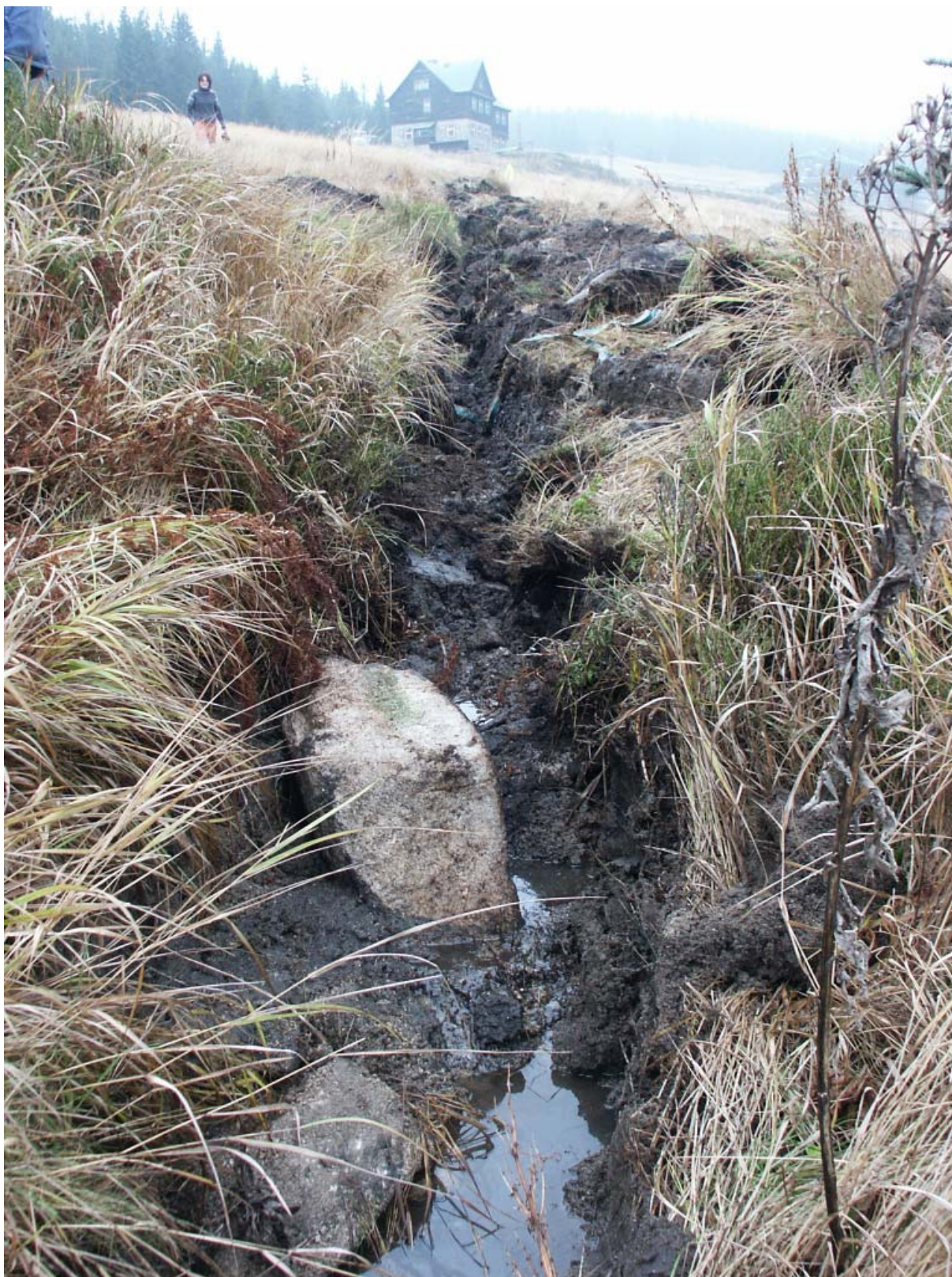
Odvodňovací kanál na Brádlkových Boudách
